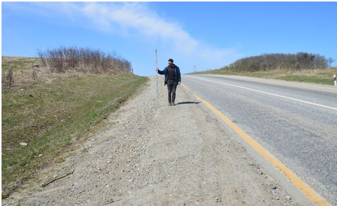
Рис. 16. Археологические исследования по титулу: «Капитальный ремонт автомобильной дороги А-156 подъездная дорога от автомобильной дороги А-155 Черкесск - Домбай - граница с Республикой Абхазия к международному центру отдыха «Архыз» и к специализированной астрофизической обсерватории Российской академии наук на участке км 7+000 - км 12+000, Карачаево-Черкесская Республика». Точка фотофиксации № 7. Вид на ЮЗ.
